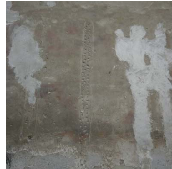
Fig. 45: Fotografía de las maestras de un enlucido histórico externo (la autora).
