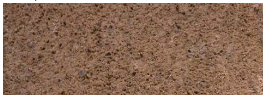
Fig. 108: Enlucido con acabado rugoso rústico o labrado (la autora).
