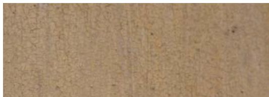
Fig. 48: Enlucido con acabado lavado (la autora).
