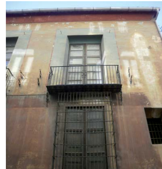
Fig. 39: Fotografía de la fachada del edificio del Colegio de Arte Mayor de la Seda en el barrio de Velluters, con diferente coloración en la zona de la cornisa, del recercado de las ventanas y de la imposta (la autora).
