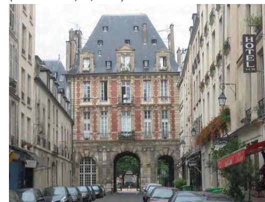
Fig. 40: Imagen de las fachadas con revestimiento exterior de yeso en la plaza de los Vosgos en París (SANZ ARAUZ, D., 2009).
