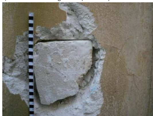
Fig. 103: Fotografía y esquema del azulejo encontrado en el enlucido de la fachada principal del edificio de la c/ Portal de la Valldigna nº4 (la autora).
