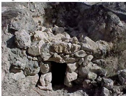
Fig. 34: Fotografía de un horno de yeso recién montado en Aguaviva, Teruel (SANZ ARAUZ, D., 2009).
