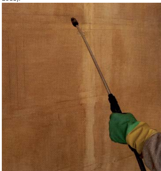
Fig. 90: Aplicación de una técnica de consolidación sobre una fachada revestida (VEGAS, F. y MILETO, C., 2011).
