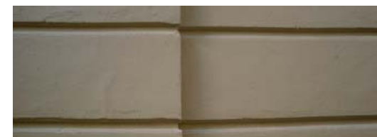
Fig. 55: Enlucido con acabado avitolado (la autora).
