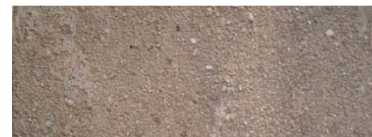
Fig. 106: Enlucido con acabado liso estucado (la autora).
