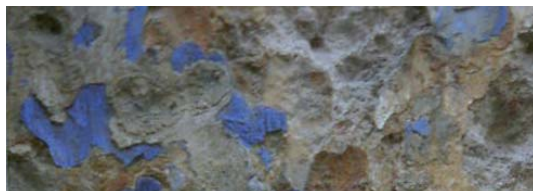
Fig. 109: Enlucido con acabado rugoso a la martellina con restos de pintura (la autora).
