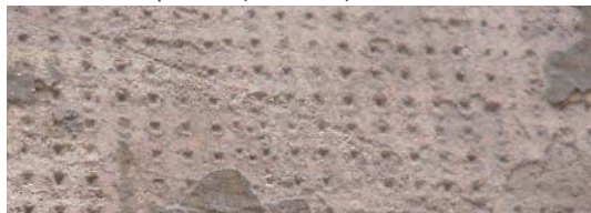
Fig. 109: Enlucido con acabado rugoso a la martellina con restos de pintura (la autora).
